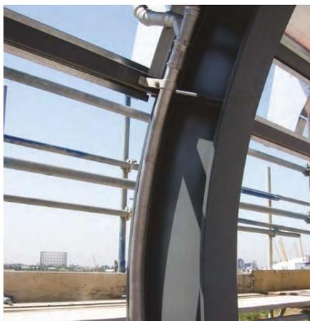
Als Fallrohr bei der Fassadenentwässerung kombiniert BLÜCHER® EuroPipe die ästhetisch ansprechende Optik von Edelstahl mit seiner Langlebigkeit und hohen Stabilität. So haben Korrosion und Vandalismus keine Chance.
